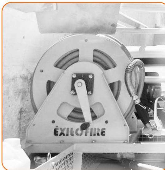
O carretel das mangueiras é formado por meio da união de chapas de aço SAE ABNT 1020, cortadas a laser, nas cores: **amarela, vermelho, laranja ou preta**, em geometria que sustentam a fixação dos outros componentes por meio de parafusos e porcas auto travantes. Tem capacidade de até 90m de mangueira.
